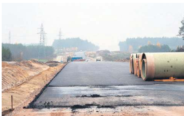
Do obwodnicy jeszcze daleko, ale drogowcy nie stoją w miejscu.
