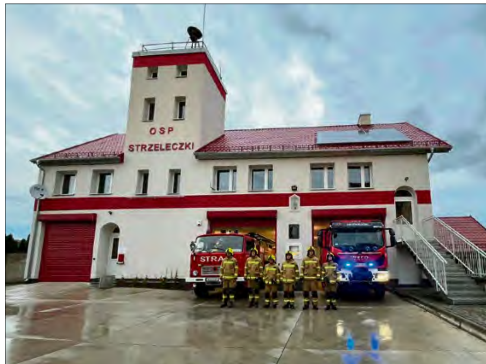
Obecnie remiza jest kompleksowo wyremontowana.
