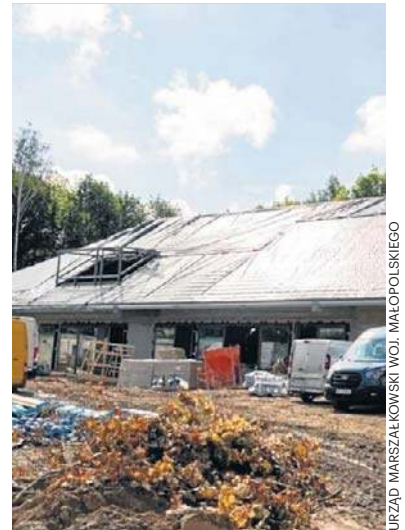
Trwają prace przy budowie centrum edukacji przyrodniczej
