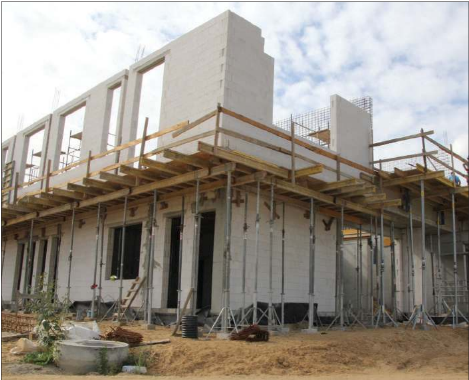
Obecnie na budowie trwają przygotowania pod wylanie stropodachu. Ma być gotowy jeszcze w tym miesiącu. W październiku budowlañcy chcą zacząć montaż dachu, okien i drzwi
