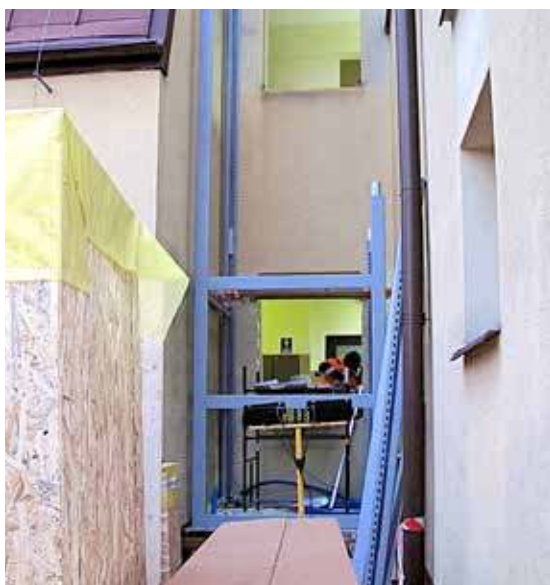
Trwa budowa windy.
