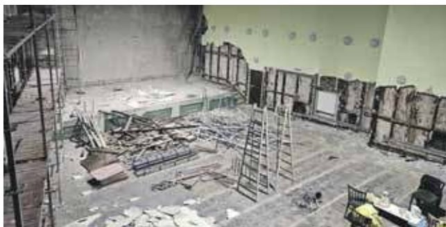
Trwa gruntowna modernizacja sali widowiskowej w Górnośląskim Centrum Rehabilitacji „Repty”
