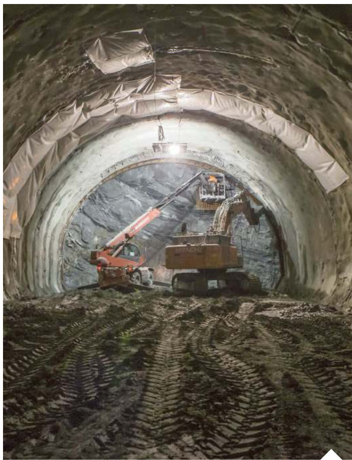
Drażenie tunelu pod górą Mały Luboń | fot. Tomasz Hamrat/Gazeta Polska
