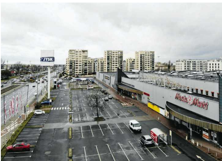
• Teren po dawnym sklepie Tesco przy ul. Górczewskiej
