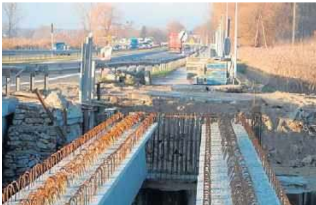
Budowa kładki w ciągu pieszo-rowerowym jest zaawansowana. Niedługo płyty pomostu będą zalewane betonem.
