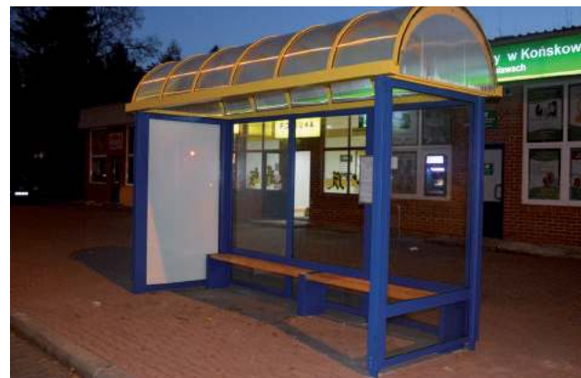
Na ulicy Norwida, w pobliżu skrzyżowania z Partyzantów stanęła wiata przystankowa. Do tej pory pasażerowie MZK czekali na autobus pod chmurką. Podobna wiata stanęła również przy ul. Wodnej obok MPWiK Puławy
