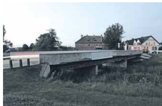
Projekt przebudowy, a właściwie budowy zupełnie nowego mostu wykonano już w 2011 r. I na kilka lat sprawa została odłożona na półkę
