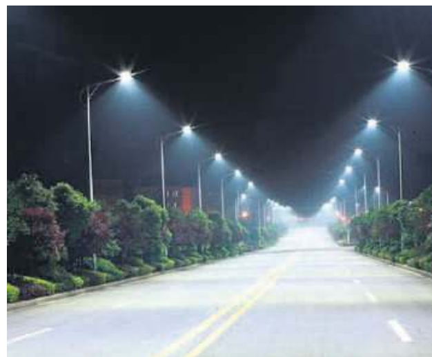
Pieniądze będą przeznaczone na wymianę 345 opraw oraz zakup i montaż systemu zarządzania oświetleniem. Fot. UG Komarów-Osada
