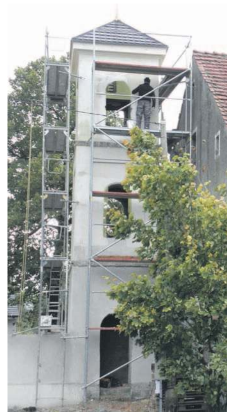
W trakcie remontu - październik 2018
