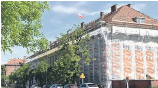
ZSP nr 2 im. Zjednoczonej Europy w Oławie jest już ostatnią szkołą, prowadzoną przez samorząd Powiatu Olawskiego, w której pozostała do wykonania termomodernizacja
