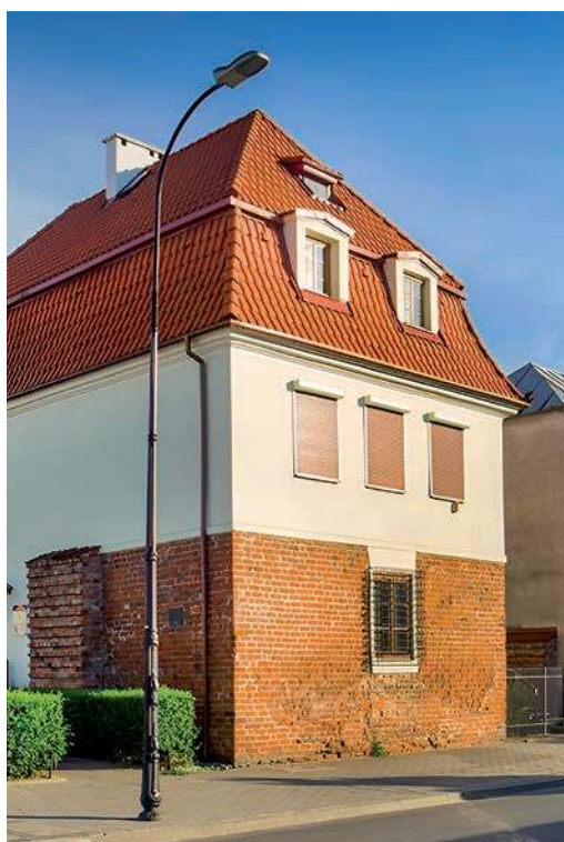
Baszta przy ulicy Zduńskiej w Plocku
