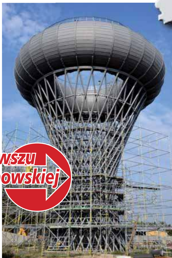
Wieża ciśnień w Ciechanowie będzie miejscem edukacji i nauki (6,3 mln zł wsparcia)
