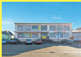
Dom handlowy w samym centrum Janowa Podlaskiego, 885 851 161
