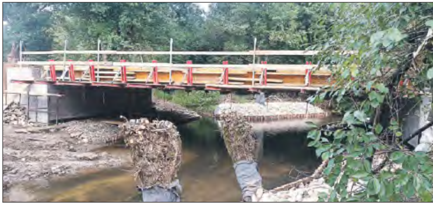
Stary most na Wildze, łączący Miastków Kościelny z Ryczyskami, został już rozebrany, a w jego miejscu powstaje nowa przeprawa
