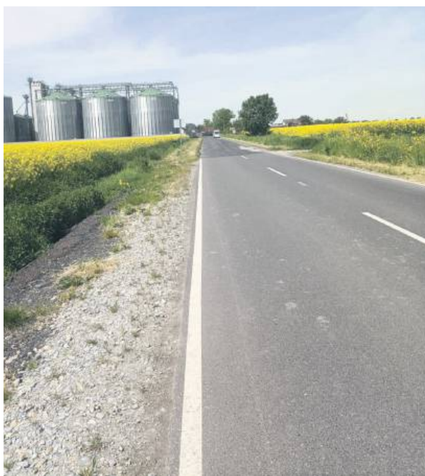
Jędrzychowice, gmina Wiązów, jedna z dróg wytypowanych do przebudowy. Foto. PZD Strzelin
