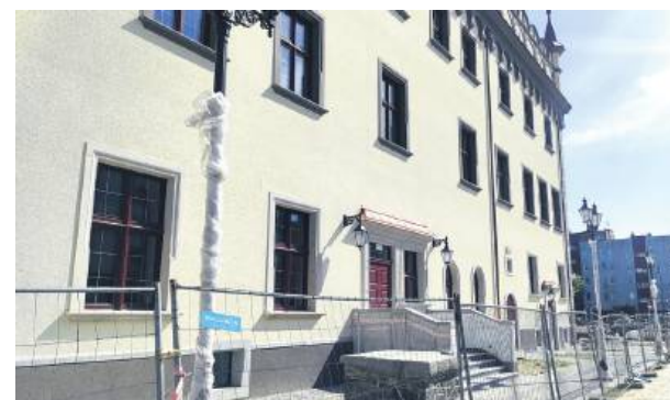
Odbudowany ratusz na strzeleńskim Rynku jest już prawie gotowy na przyjęcie urzędników i petentów
