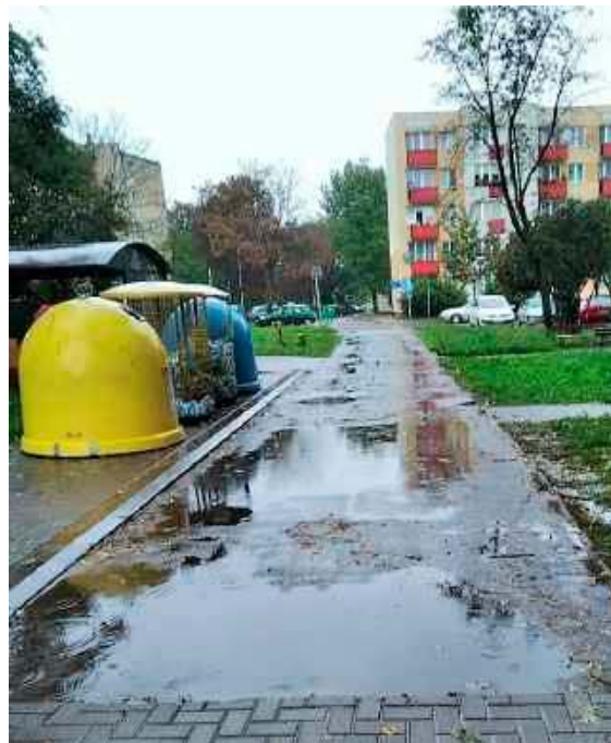
Po deszczu na chodniku tworzy się wielka kałuża
