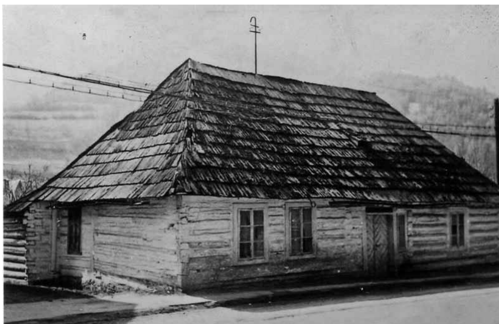
Poruszenie wśród mieszkańców Szczawnicy wywołało zdjęcie białego domu przy ulicy Szalaya.
