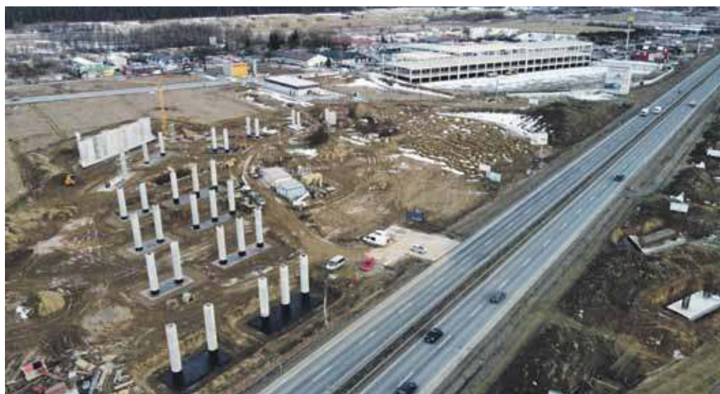
Filary powstającego węzła Nowy Targ Południe, a w głębi szkielet powstającej Galerii Podhalańskiej.
