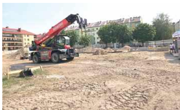
Przy ul. Wyszyńskiego od kilku tygodni trwają już pierwsze prace
