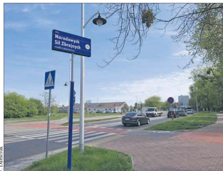
Ulica Narodowych Sił Zbrojnych wymaga remontu
