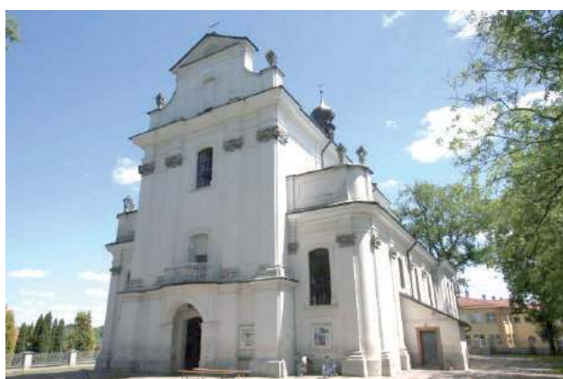
Część radnych Tarnogrodu wniosła o znacznie większą dotację na remont elewacji kościoła
