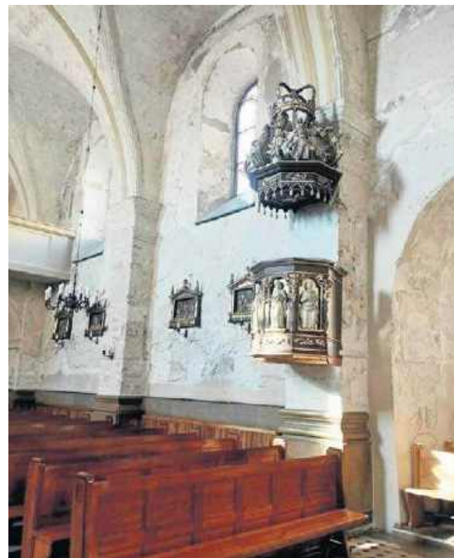
Odkryto wejście od plebanii na ambonę
