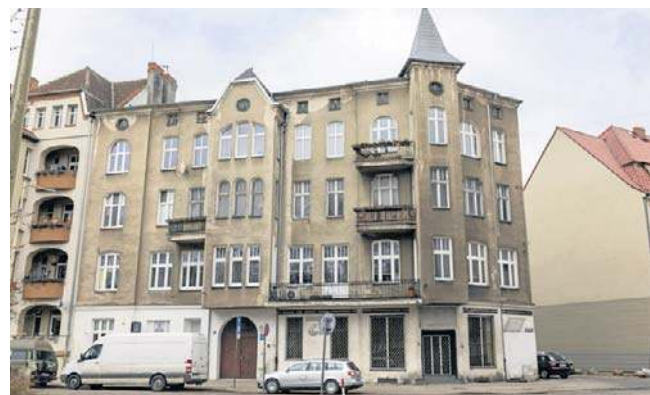
Jedną kamienic, która zostanie wyremontowana za dotację SSR jest budynek przy pl. Broniewskiego 1
