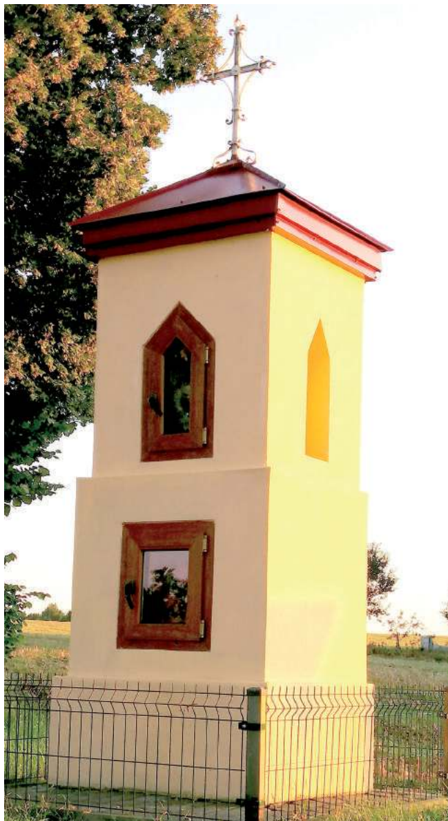
W kapliczce w Kolonii Białobrzegi wymieniony został zniszczony dach, położony nowy tynk, całość odmalowano. Uporządkowane jest otoczenie kapliczki, położona nowa kostka, dodane ogrodzenie
