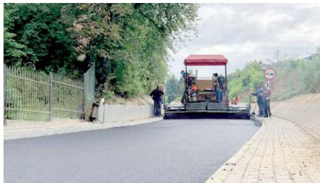
Na ul. Partyzantów w Wąwolnicy położono asfalt. Do tej pory pokryta była brukiem. Część kosztów inwestycji pokryła rządowa dotacja
