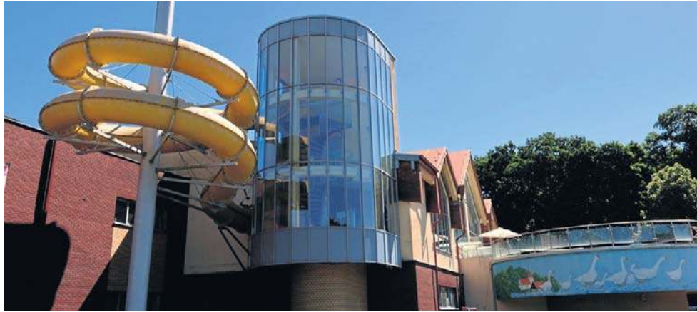
Kompleks Strefa 360 Park Redzikowo przechodzi modernizację
