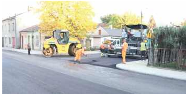
Na ulicach Tadeusza Kościuszki oraz Szkolnej trwa układanie nowych warstw asfaltu. Mieszkańcy od dawna czekali na poprawę stanu tych ulic (fot. Jerzy K. Wojtaś)
