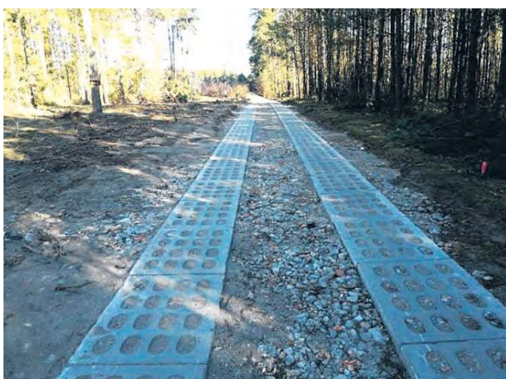
Nogawicka i kolejne metry utwardzonej drogi.
