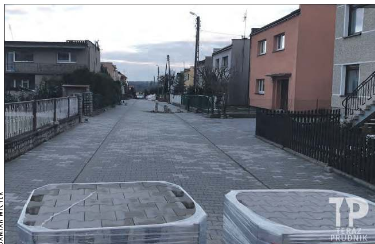
Ulica Reymonta otrzymała nową nawierzchnię
