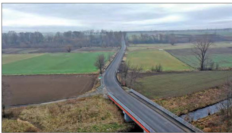
Fragment wyremontowanej drogi Trzebinia-Skrzypiec
