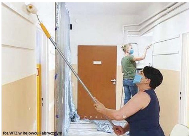
Gdy zajęcia były zawieszane pracownicy WTZ w Rejowcu Fabrycznym przeprowadzili remont pomieszczeń
