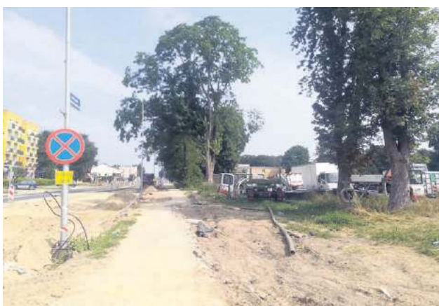
Oświetlenie uliczne przy ul. Piłsudskiego zmodernizowano rok temu. Obecnie niektóre z latarni trzeba nieco przestawić, by nie kolidowały z traktem pieszym i ścieżką rowerową.
