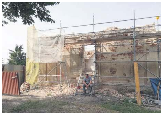
Budowlańcy mają m.in. usunąć górną warstwę cegieł i ułożyć nową, zabezpieczyć ściany.
