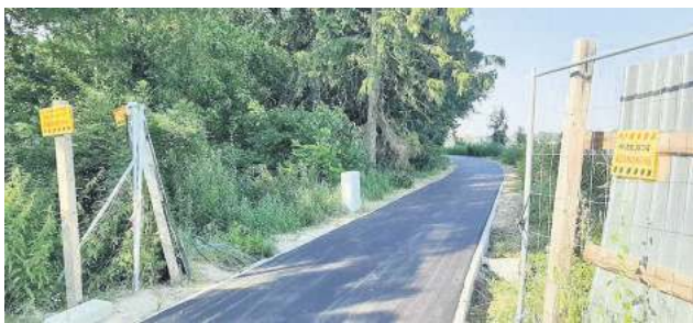
Jeszcze w zeszłym tygodniu przy każdym z wejść nad zalew znajdowały się tabliczki z informacjami, że to plac budowy, a przejście jest zabronione.
