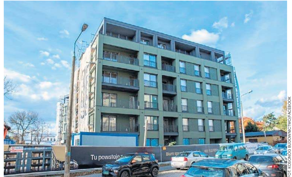
FOT. KOSONÓG BUDOWNICTWO/FACEBOOK
