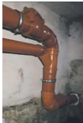
Wymieniona rura kanalizacyjna
