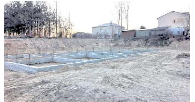
Tak wyglądał plac budowy w grudniu 2019 r. Wykonawca inwestycji nie zrealizował nawet 20 procent planu rocznego
