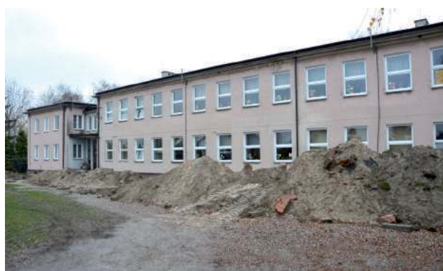
Tak wygląda na chwilę obecną teren wokół SP w Borowej. Budynek obecnie poddawany jest termomodernizacji, która zostanie zakończona już niebawem
