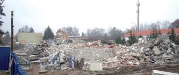
Budynek w zbiegu ul. Słowackiego i Lubelskiej został wyburzony. W jego miejscu powstanie nowa siedziba KP PSP. Budowa potrwa dwa lata
