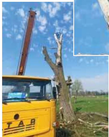
Platforma dla bocianów została zamontowana na jednym z drzew
