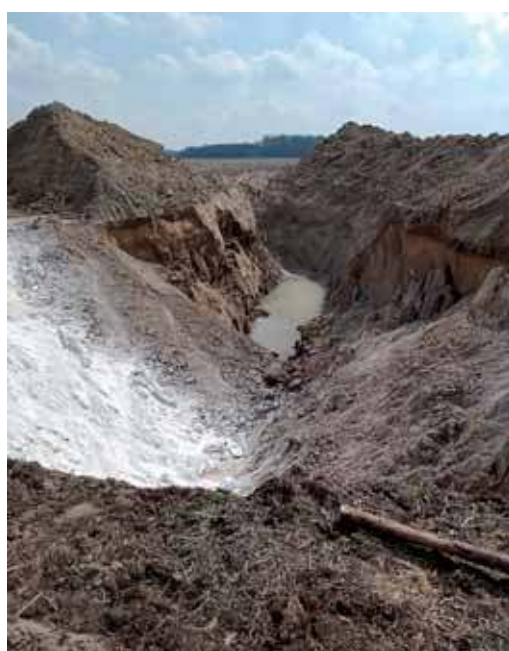
Protestujący twierdzą, że dół nie jest zabezpieczony, stąd obawy, żeby skażenie nie dostało się do wód gruntowych i okolicznych studni
