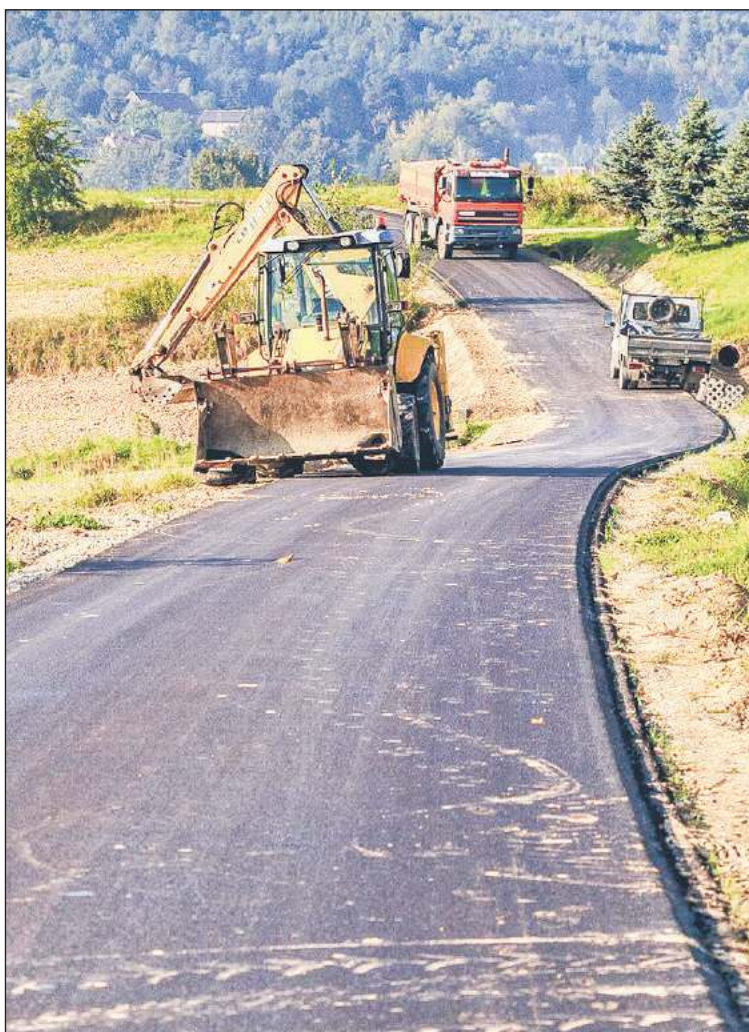
Na drodze pomiędzy Pilznem a Słotową trwają prace wykończeniowe.
