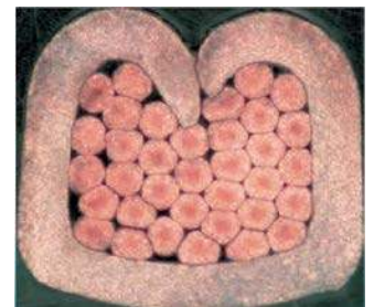
Fotografia 21. Przekrój nieprawidłowo zaciśniętego konektora. Zbyt płytkie zaciśnięcie doprowadziło do powstania luk pomiędzy sąsiadującymi drucikami, głównie po lewej stronie oraz na dole ( http://t.ly/622tS )
