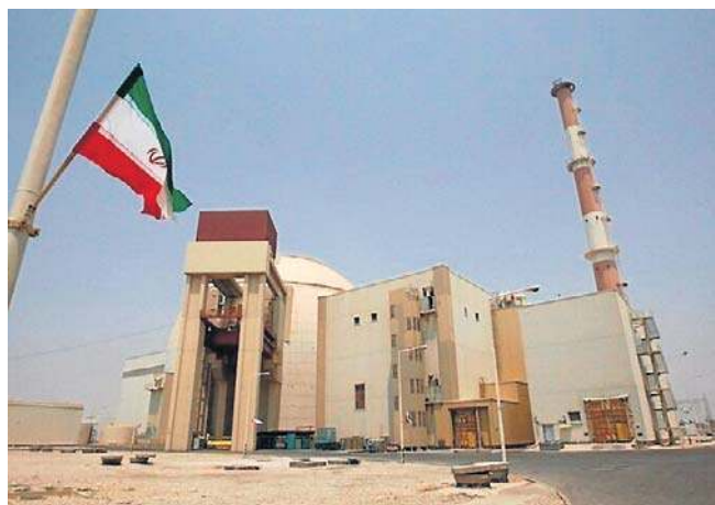
Buszejr to kluczowa irańska elektrownia jądrowa. Została uszkodzona po ataku rakietowym
