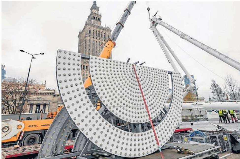
Na Placu Defilad trwa montaż największego w Polsce „diabelskiego młyna”. Wysoka na 55 metrów konstrukcja będzie jedną z atrakcji świątecznego jarmarku
