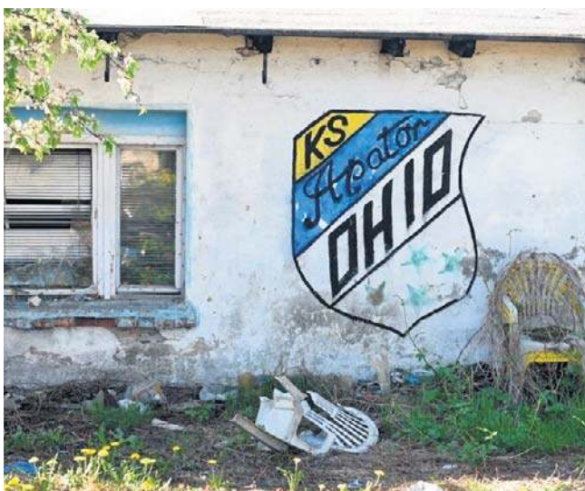
Czas wyburzeń w „Ohio” - rok 2021
