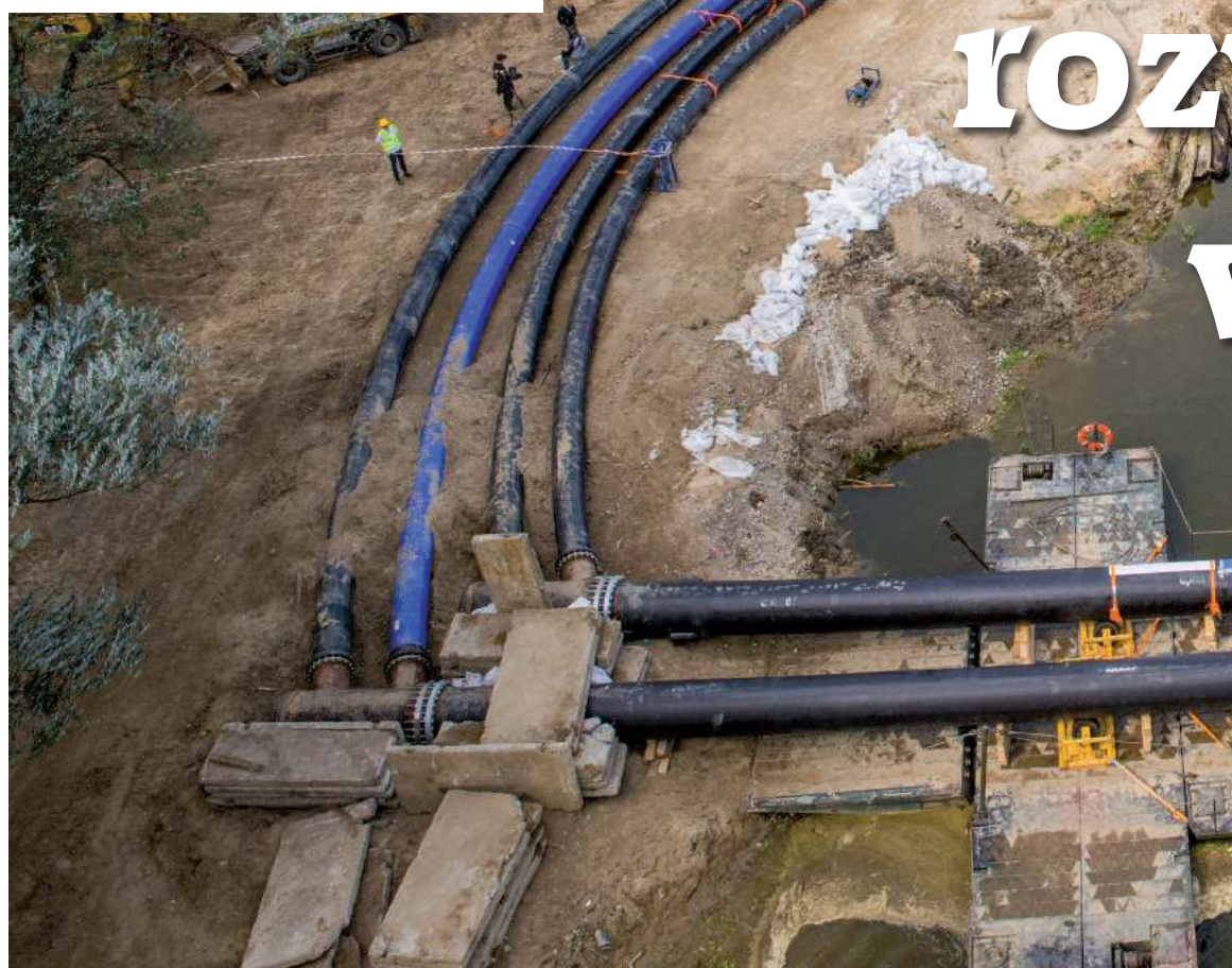
Wczoraj rurociągiem na moście pontonowym popłynęły warszawskie ścieki | fot. Tomasz Hamrat/Gazeta Polska
