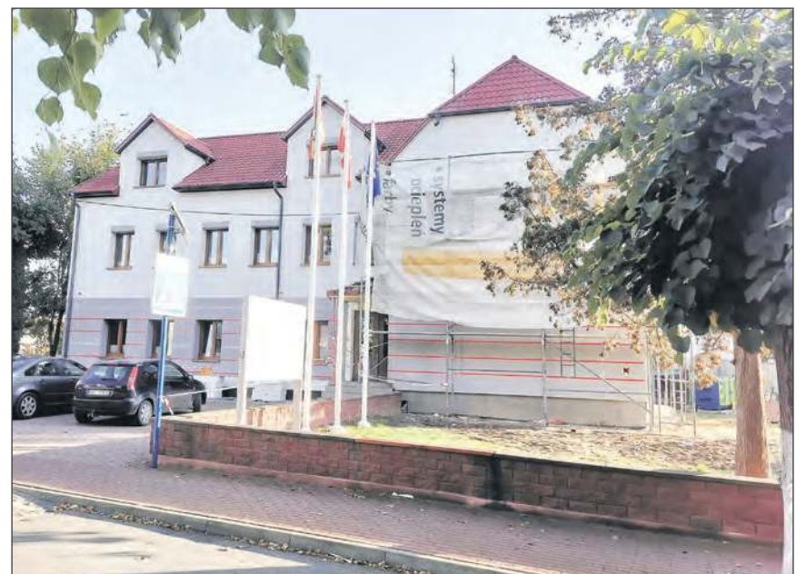
Termomodernizacja budynku Urzędu Gminy w Stężycy to tylko część zaplanowanej inwestycji mającej na celu przeciwdziałanie skutkom zmian klimatycznych
