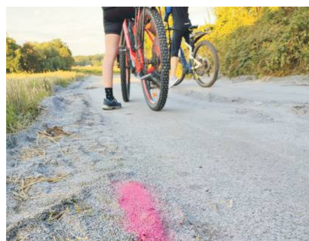
W Gęsińcu między ul. Świerkową a Widokową trwają prace polegające na utwardzeniu drogi
