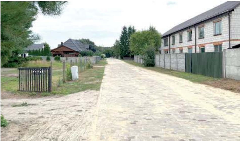
Do budowy nawierzchni ulicy Spacerowej wykorzystano kostkę pozyskaną z rozbiórki innych ulic miejskich oraz rewitalizacji placu Wolności
