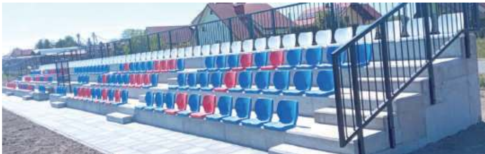
W ramach zadania została wybudowana żelbetowa, niezadaszona trybuna sportowa w formie schodkowej na gruncie przy boisku piłkarskim w Księżpolu
