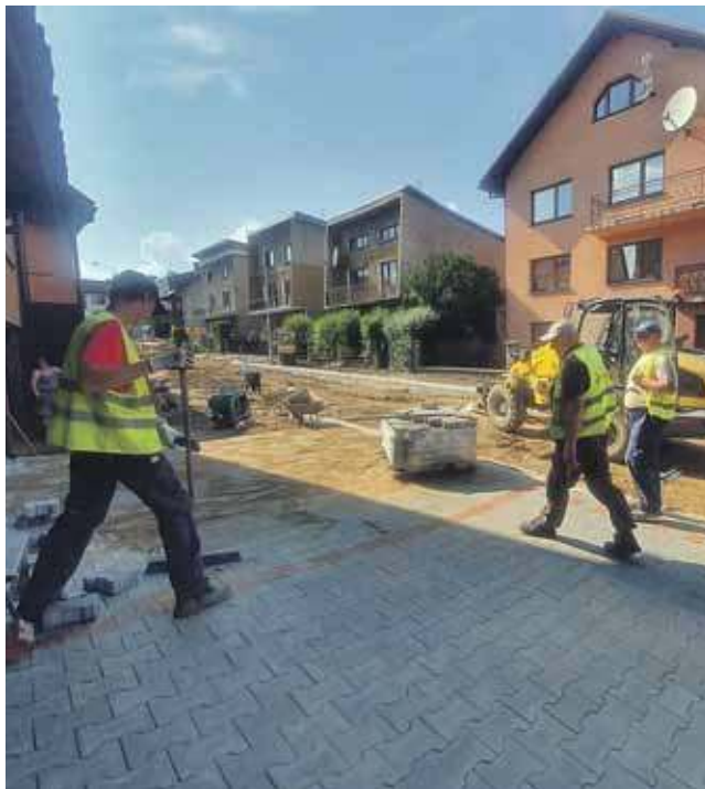
Prace przy ul. Długiej zakończą się jesienią.
