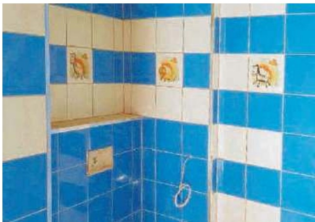
W łazienkach są kolorowe płytki z detalami dekoracyjnymi. Trzeba jeszcze zamontować m.in. umywalki, brodziki, kabiny
