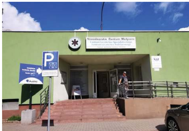
Remont obejmuje część gdzie znajdują się POZ
